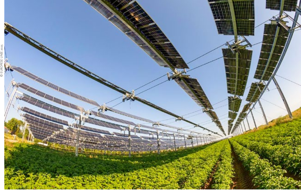
Een agro-fotovoltaïsche installatie op een Frans landbouwbedrijf (Picardië) als innovatie én bijverdienste. Zonnepanelen leveren energie, beschermen de teelten en besturen tegelijk een efficiënt irrigatiesysteem.
