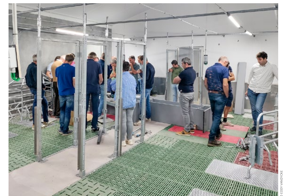
Opbouw vrijloopkraamhok zeugenstal PVL Bocholt.
