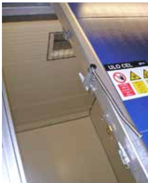
Staalname via een controlevenster bovenaan. Voorzie het venster van een valrooster!
