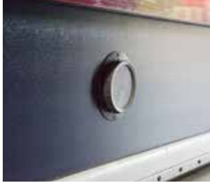
Staalname via een toegangsluik in de deur.
