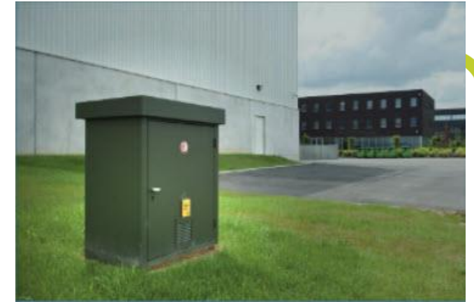
Gascabine met G65 rotorgasmeter
