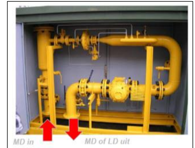
G65 rotorgasmeter met reduceerlijn (drukregeelaar) van 15 bar naar 100 mbar
