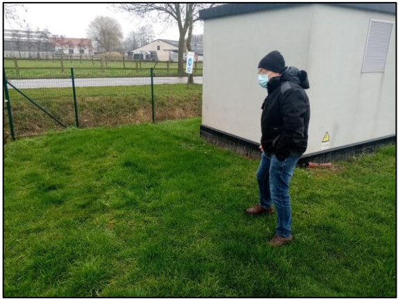
Plaatsbepaling gasmeterkast naast E- cabine
